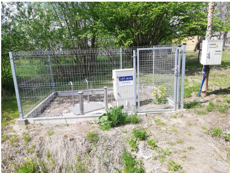
Rys 8. Istniejąca przepompownia ścieków Ob. PŚ-istn. Obręb Wieniawa dz. nr 199 (przeznaczona do modernizacji- wymiana pomp zatapialnych- zagospodarowanie terenu)
