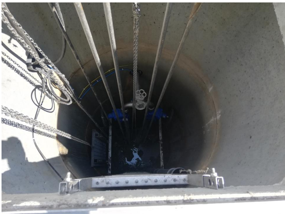
Rys 9. Istniejąca przepompownia ścieków Ob. PŚ-istn. Obręb Wieniawa dz. nr 199 (przeznaczona do modernizacji- wymiana pomp zatapialnych- wnętrze zbiornika)
